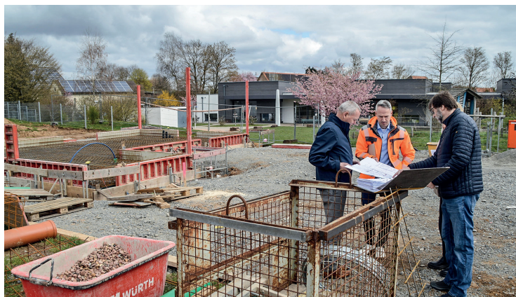
v.l. Erster Bürgermeister Thomas Stamm, Bauamtsleiter Andreas Burk und Architekt Johannes Hettiger informierten bei einem Pressetermin über den Baufortschritt des Jugendraums in Altfeld. Foto: Marcus Meier
